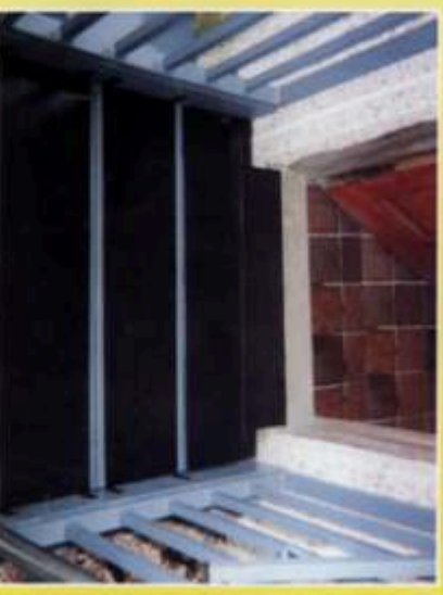
Lift in angehobener Position - Elemente bilden eine Brücke
